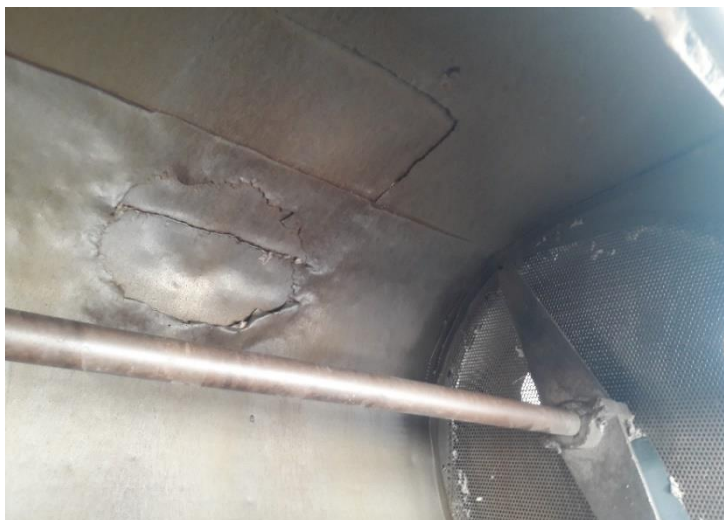
Рис.1.4. Внутренний вид стенки сепаратора СС-15А после ремонта.
